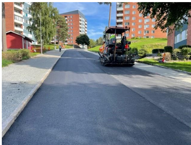
Beläggningsarbete på Ringvägen i Fagersta
