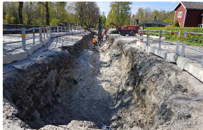
VA-sanering på Gyllentäktsvägen-Stålgatan
