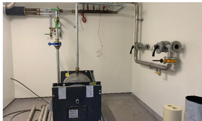
Upprustning metangasanläggning, Persbo reningsverk
