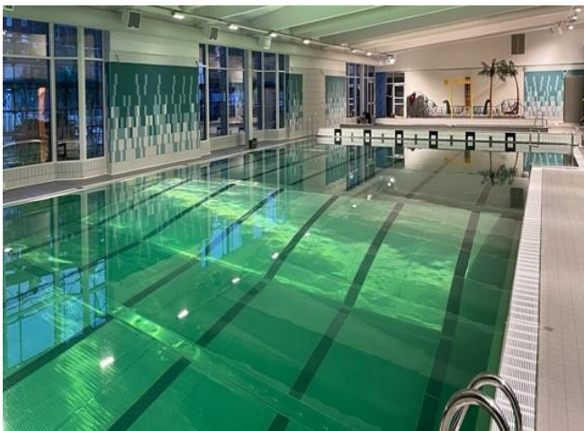
Renovering Fagerstahallen, vattenskada
