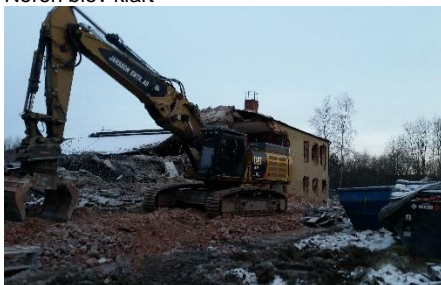
Rivningsarbetet av Gamla vattenverket vid Noren blev klart
