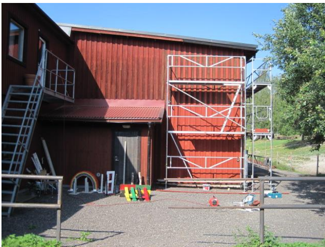
Målningsarbeten vid Rådhuset i Hedkärra
