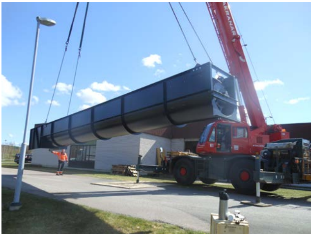
Lyft av ny inmatningsskruv till avloppsreningsverket
