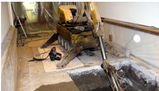
Ledningsjobb under plattan i Öjersbogården
