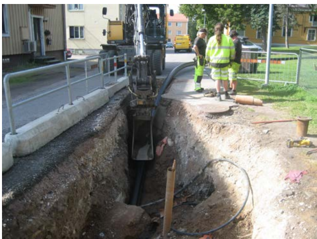
Reliningsarbeten på Tingsgatan-Gruvvägen
