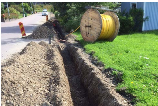
Fibernetläggning i trottoar
