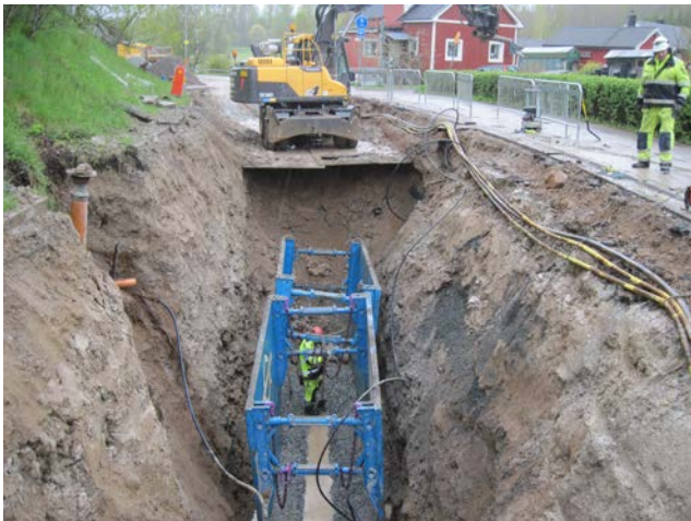
Ledningssanering Gamla Norbergsvägen
