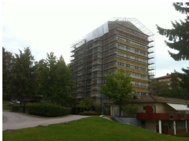
Ombyggnad av ventilation och fönsterbyte vid Koltrasten
