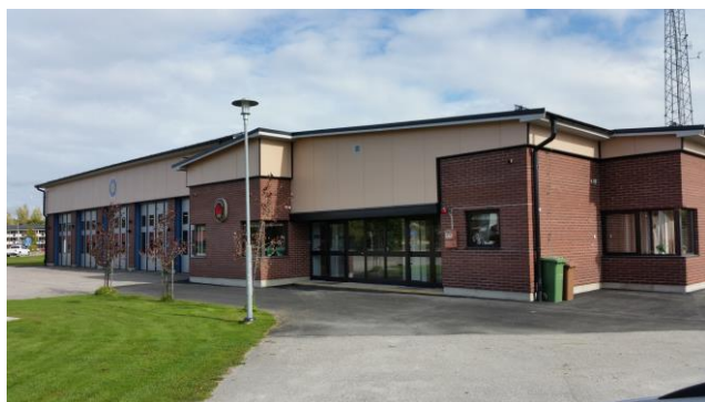
Nytt yttertak på brandstation i Norberg
