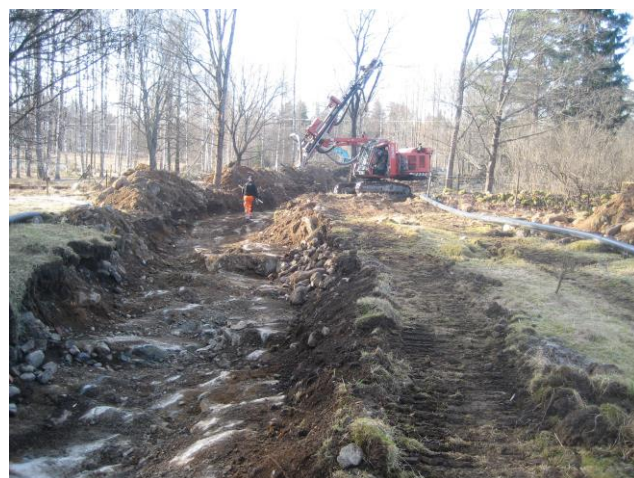
Sprängning för ny vattenledning till Kärrgruvan för att höja säkerheten i vattenleveransen
