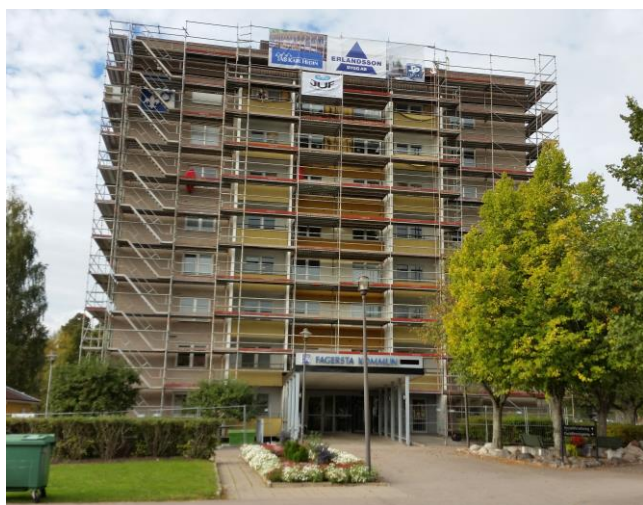
Fasad och fönsterbyte på Norbergsvägen 19 och 21
