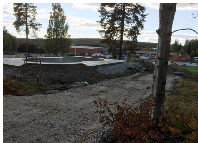
Skatebowl byggs i korsningen Ringvägen/Norrbyvägen
