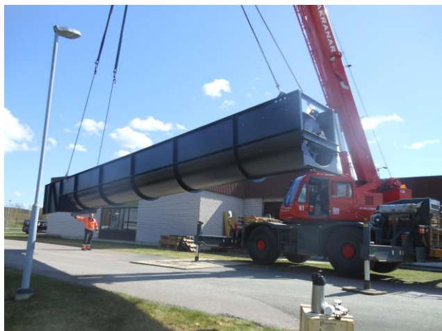
Lyft av ny inmatningsskruv till avloppsreningsverket
