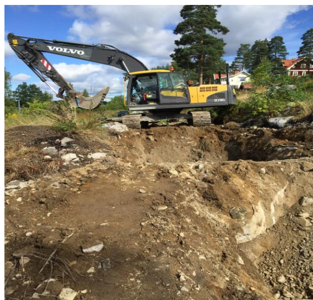
Nyanläggning av vatten och avlopp i Ängelsberg
