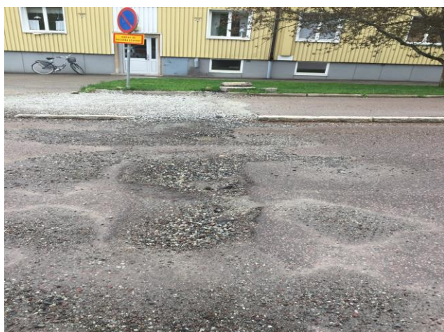
Återställning efter fiberschakt
