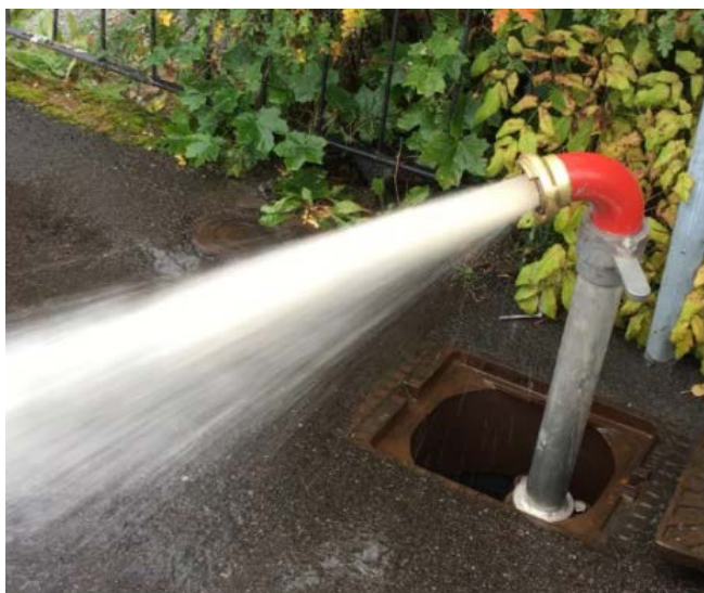
Underhållspolning av vatten nätet
