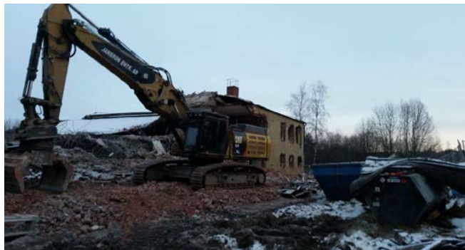
Rivningsarbete vid Noren
