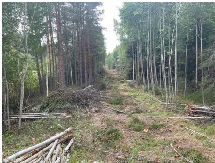
Röjning av huvudvattenledning
