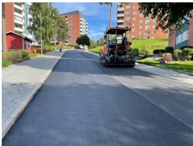
Beläggningsarbete på Ringvägen
