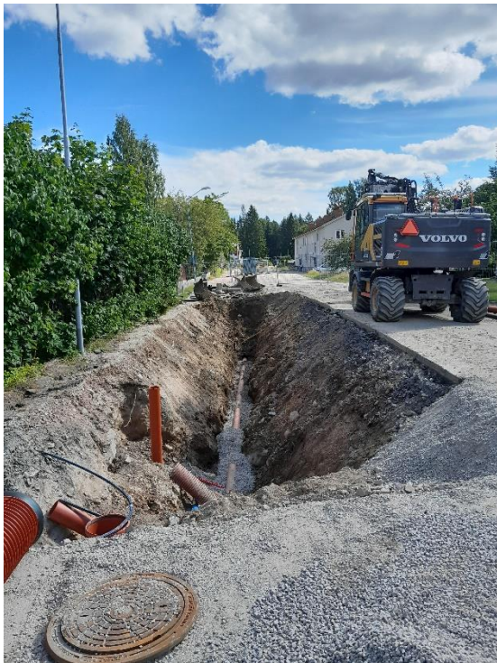
VA-sanering längs Järnväggsgatan
