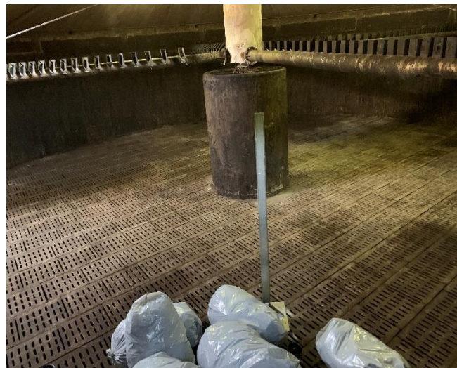
Efter 500 tons tömning av sten i biologen
