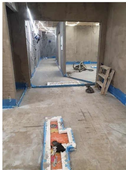
Figur 1 Renovering Fagerstahallen omklädningsrum
