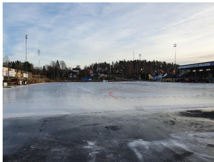
Byte kylanläggning Västanfors IP
